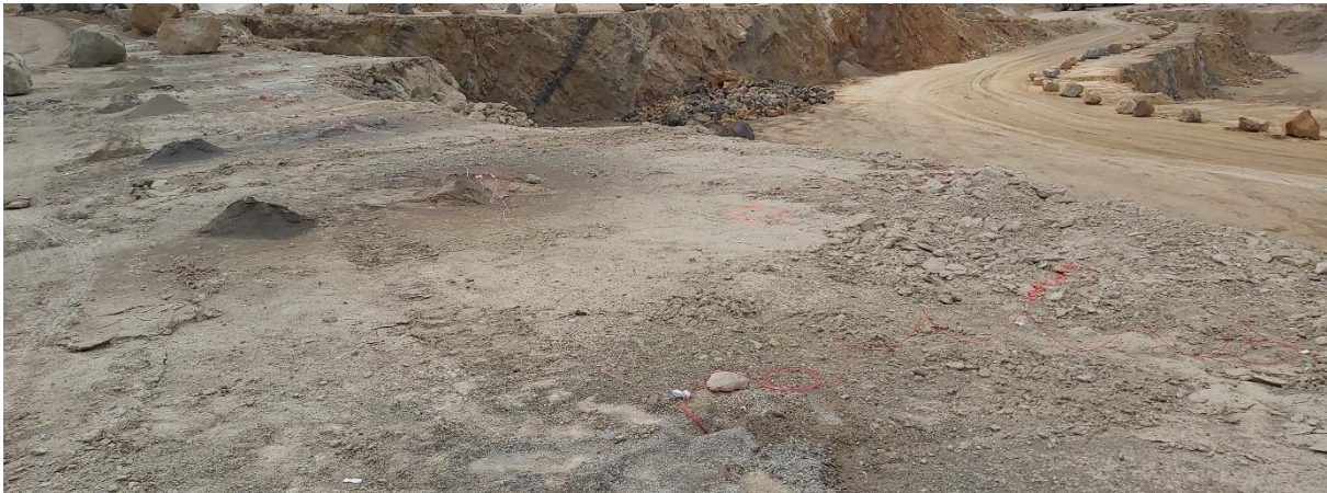
Figura 41 - Desmorte nº 108.21 da pedreira do Outão imediatamente após o carregamento dos furos
