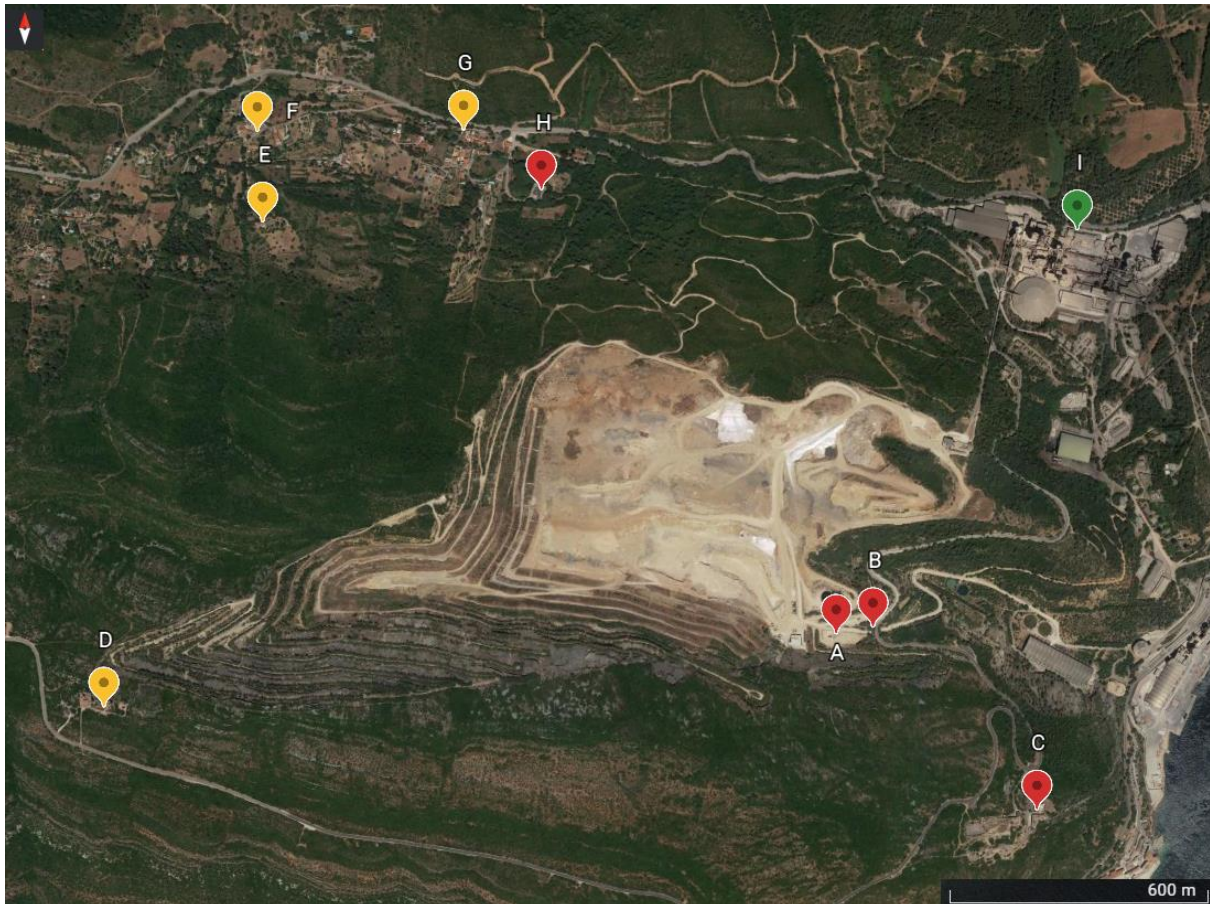
Figura 23 - Localização dos locais de monitorização na pedreira do Outão. (Google Earth)
